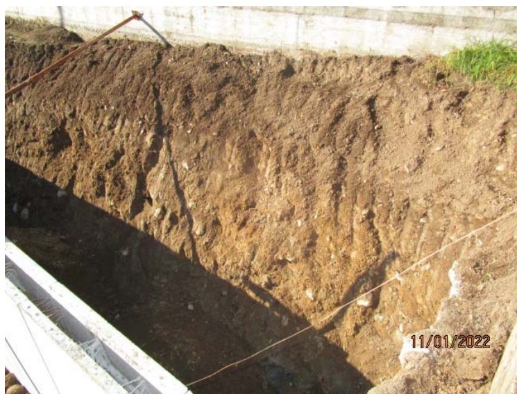
Scavo in ambito di cantiere nei pressi del lago Sartirana
